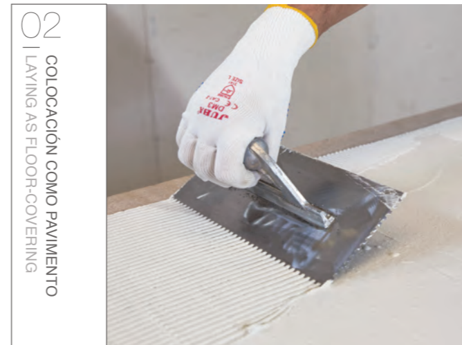
03 | COLOCACIÓN COMO PAVIMENTO LAYING AS FLOOR-COVERING
