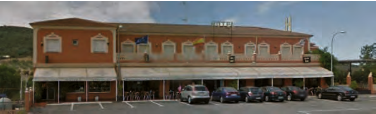
ANTES BEFORE AVANT VORHER
